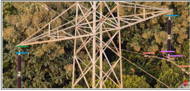
[그림 3] Edge AI 기반 송전탑 객체 인식(출처: The Drone Expert, 2025)
